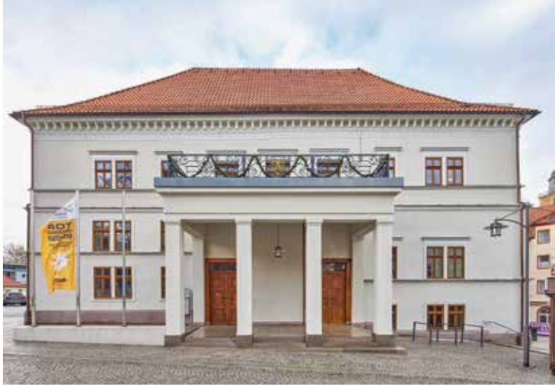
较少的干预措施：修缮后的松德斯豪森市政厅。
