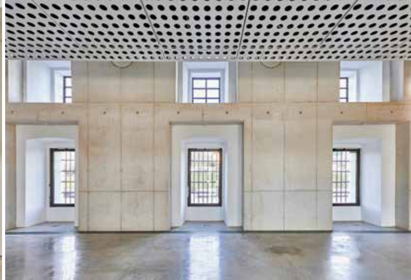
在内部，现有的立面前面是钢筋混凝土墙。
