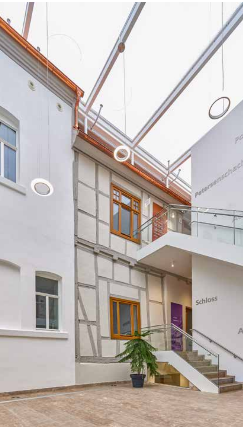
现已受到保护：半木结构的外墙属于有屋顶庭院的一部分。
